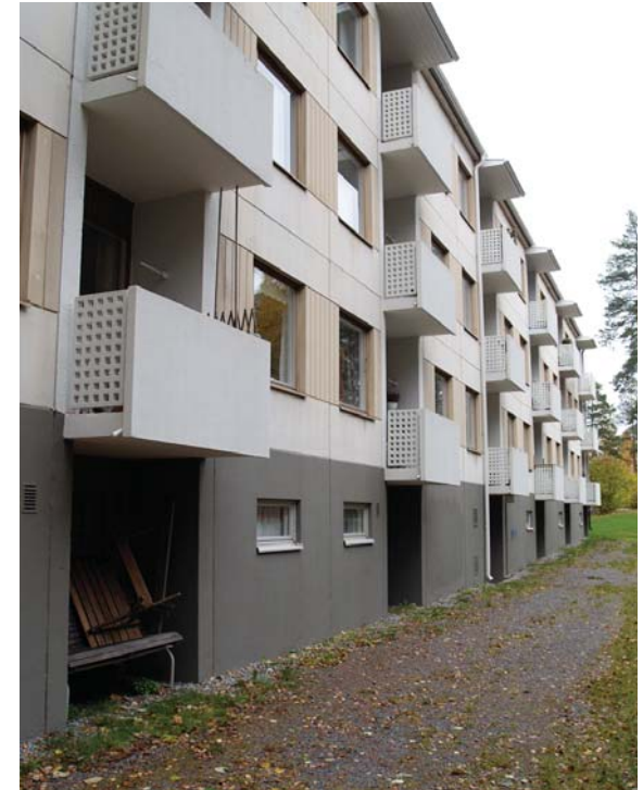
Sisäänvedetyt parvekkeet parvekeristikkoineen.
